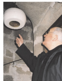
Gerät zur Trockenlegung.
